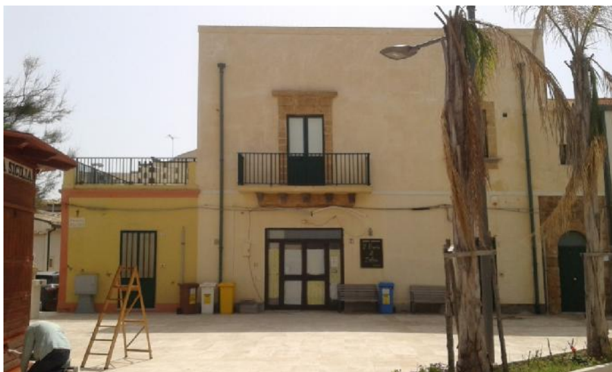
Vista lato Piazzetta Torre
